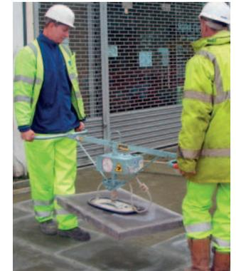
Flexibel und kraftvoll – für saugdichte Werkstoffe wie z.B. Granit oder Betonteile bis 150 kg. Mit Akkuantrieb.
