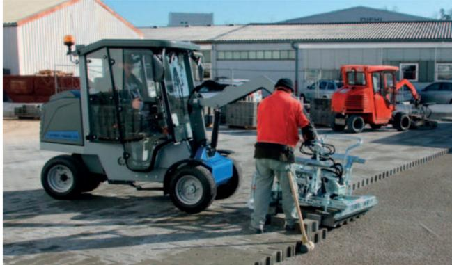
Sechs Stunden Pflaster verlegen – laufruhig, geräuscharm und ohne Abgase. Die weltweit erste vollelektrische Verlegemaschine ist auf Ausdauer ausgelegt. Von besonderem Vorteil auch beim Einsatz in Bereichen mit verschärften Grenzwerten für Abgas- und Schallemissionen, z.B. in Tiefgaragen oder in der Nähe von Krankenhäusern und Schulen.
