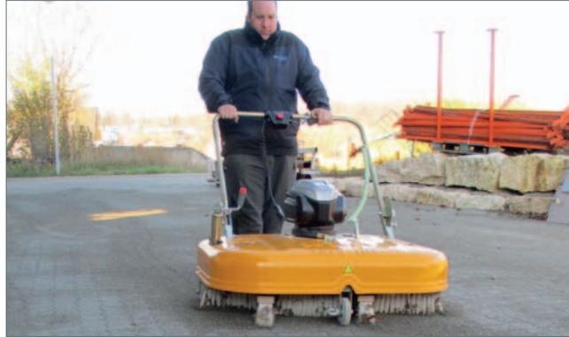
Mit dem elektrischen Pflasterverfugungsgerät EF-H-GREENLINE gelingt das Einbringen von Fugenmaterial (trocken oder mit Wasserzugabe) schnell, geräuscharm und abgasfrei. Ein großer Vorteil beim Arbeiten in Innenstädten oder Wohngebieten und ein wichtiger Beitrag zum Arbeitsschutz für den Bediener.
