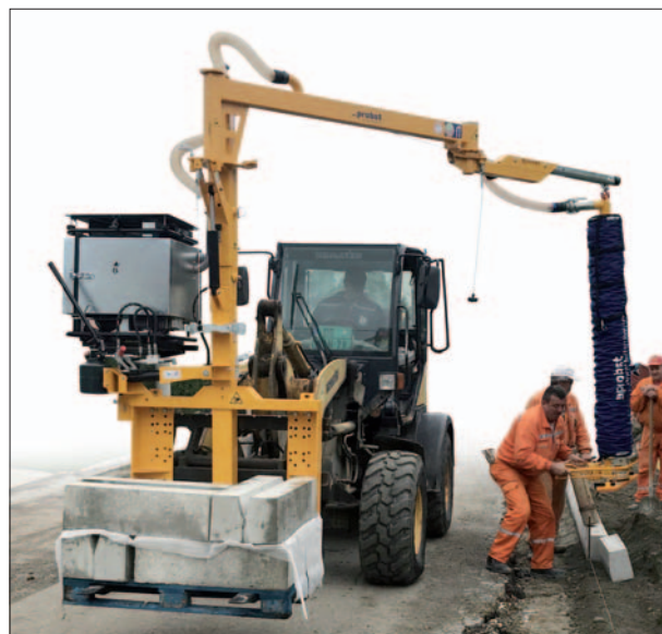
路沿石真空吸盘安装设备 JUMBO-BV-VARIO
