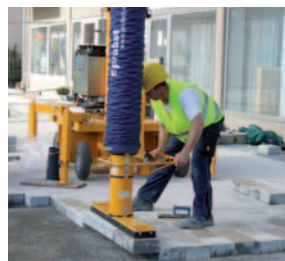
大尺寸砖块真空铺装机 JUMBOMOBIL JM-VARIO
