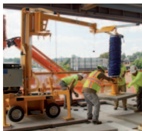
大尺寸砖块真空铺装机 JUMBOMOBIL JM-VARIO
