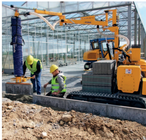
履带式路沿石安装机 TRANSMOBIL TM
