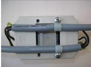
8. Coloque el cable hacia atrás alrededor del marco de instalación y fíjelo con las abrazaderas.
