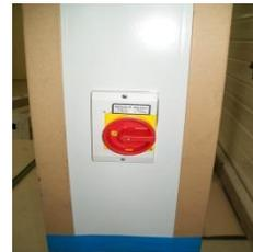
10. A continuación, coloque la tapa en el marco de instalación y atorníllela.
