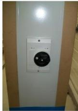
9. Coloque la tapa en el marco de instalación y atorníllela.
