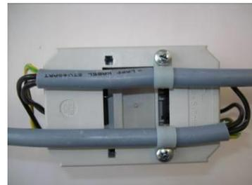
5. Coloque el cable hacia atrás alrededor del marco de instalación y fíjelo con las abrazaderas.
