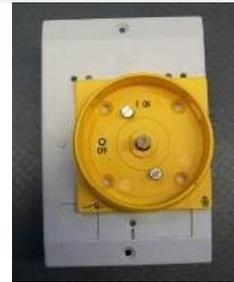
2. Atornille el panel del marco de montaje en el interruptor. Esto se hace a través de la placa de montaje amarilla del interruptor principal. Para ello, utilice los agujeros marcados (2) en la tapa. El logotipo de Glöckner Möller (1) sirve de guía.
