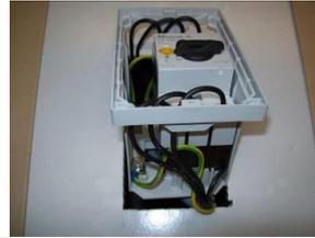
7. Empuje los cables hacia atrás en la columna e inserte el marco de instalación en la columna de la grúa. A continuación, atornille el marco de instalación a la columna con las garras adjuntas.
