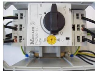
3. Conecte el conductor neutro y las tierras al marco de montaje y encaje el interruptor de protección del motor en el marco de montaje y conéctelo
