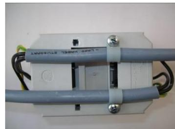
5. Kabel nach hinten um den Einbaurahmen legen und mit den Kabelschellen befestigen
