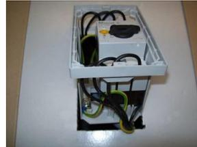
7. Die Kabel nach hinten in die Säule schieben und den Einbaurahmen in die Kransäule einsetzen. Dann den Einbaurahmen mit den beiliegenden Krallen an der Säule verschrauben.
