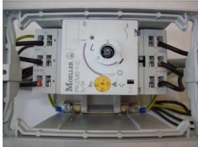
6. Vom Motorschutzschalter den schwarzen Drehknopf entfernen. Hierzu mit einem kleinen Schlitzschraubendreher vorsichtig unter den Knopf fahren und ihn ab hebeln.
