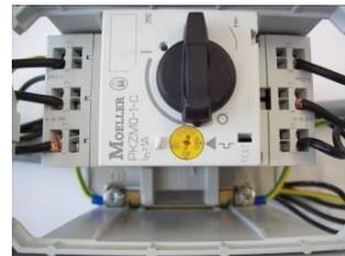
3. Nullleiter und Erdungen am Einbaurahmen anschließen und den Motorschutzschalter in den Einbaurahmen einrasten und anschließen
