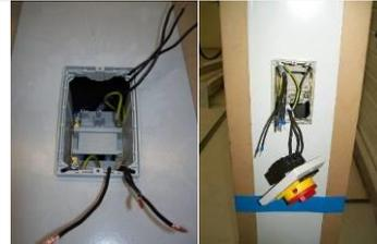
9. Den Einbaurahmen in die Kransäule einsetzen und die Kabel nach außen führen, bevor der Rahmen endgültig fixiert wird. Den Einbaurahmen mit den beiliegenden Krallen an der Säule verschrauben und anschließend die Dichtung montieren. Hauptschalter anschließen Motorschutzschalter auf Nennwert des Motors einstellen
