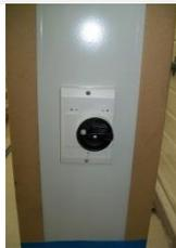
9. Die Blende auf den Einbaurahmen aufsetzen und verschrauben.
