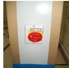
10. Anschließend die Blende auf den Einbaurahmen aufsetzen und festschrauben.
