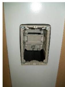
7. Préparez les câbles pour le raccordement. Il est recommandé de dénuder les câbles sur env. 15 cm.
