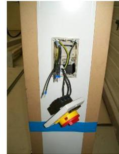
9. Pour faciliter le montage, fixez les deux câbles ensemble avec un serre-câbles, comme le montre l'illustration. Puis, repoussez les câbles vers l'arrière dans la potence, placez le cache sur le cadre et vissez.
