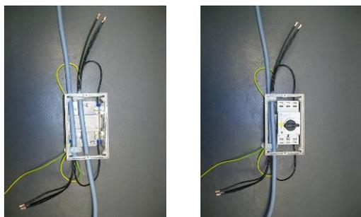
4. Le contacteur-disjoncteur dispose de bornes à ressorts. Utilisez un petit tournevis à fente comme le montre l'illustration. Lorsque vous appuyez vers le bas, la borne s'ouvre et le câble peut être introduit dans l'orifice correspondant.
