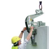
Exaktes Versetzen von L-Steinen: Aufhängeöse kann dem Schwerpunkt von gängigen Elementen angepasst werden, damit diese senkrecht hängen.
