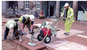
Komplettgerät zur zügigen Vakuumverlegung von stark porösem Verlegegut, wie Natur- und Betonsteinplatten.
