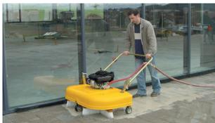
Schnelle & günstige Verfüllung der Pflasterfugen auf kleineren und mittleren Flächen. Fugenmaterial kann trocken oder nass eingeschlämmt werden.
