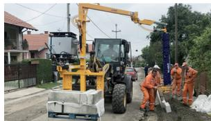
Vakuum-Schlauchheber mit innovativen Sicherheits-Features: Verlegen Sie Bordsteine schnell, sicher und ergonomisch.
