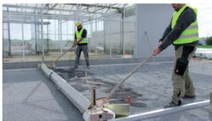
Exakte Planumserstellung durch höhenverstellbare, leichtgängige Rolleneinheiten mit Leitblech und hochklappbarem Abweiser.
