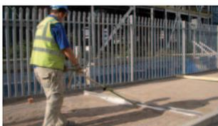
Stadia manuale per la preparazione di sottofondi in cantieri medio/piccoli: risparmio di tempo ed ergonomia, senza ingiunocchiarsi.
