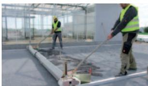
Preparazione precisa dei sottofondi grazie alla regolazione dell'altezza e alle ruote scorrevoli, con piastra guida e deflettore pieghevole.
