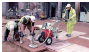
Unità vacuum completa per la posa di materiali molto porosi come lastre in cemento.
