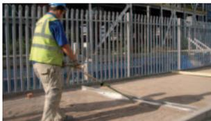
Ensemble d'outils manuel pour le nivellement efficace de petites et moyennes surfaces de lit de pose : Gain de temps et ergonomie, sans s'agenouiller.
