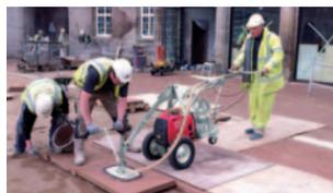
Appareil complet pour la pose rapide sous vide de matériaux très poreux, tels que les dalles en pierre naturelle et en béton.
