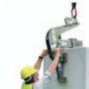
Manutention précise des murs en L : l'anneau de suspension peut être ajusté au centre de gravité des éléments afin qu'ils pendent verticalement.
