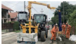
Tube de levage avec ventouses et dispositifs de sécurité innovants : Posez les bordures rapidement, en toute sécurité et de manière ergonomique.
