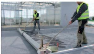
Réglage précis du niveau du lit de pose grâce à des rouleaux réglables en hauteur fonctionnant sans à-coups, avec plaque de guidage et déflecteur rabattable.
