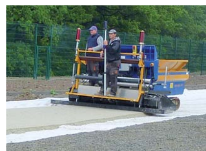
Praca przy budowie boiska
